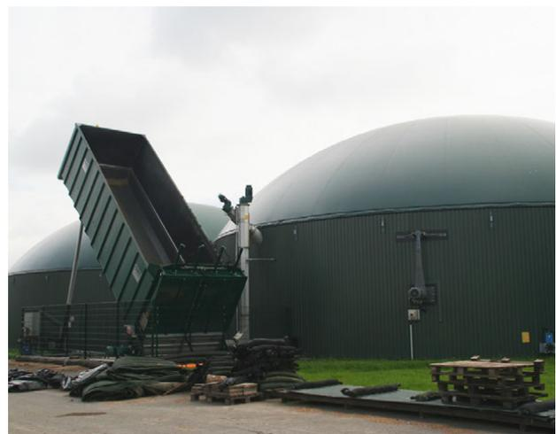
Biogasanlage mit Haupt- und Nachfermenter, welche mit nachwachsenden Rohstoffen betrieben wird
