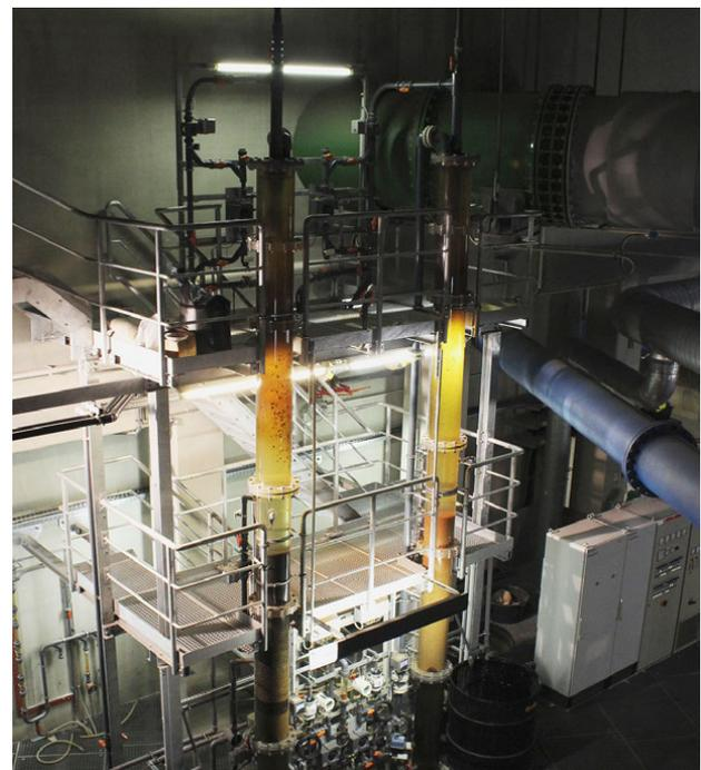
Zweischicht-Schnellfilter der Pilotanlage in der Oberflächenwasser-Aufbereitungsanlage Tegel
